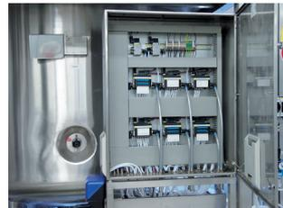
CPV-Ventilinseln können über Wandmontage oder auf Hutschiene im Innern des Schaltschranks platziert werden.
